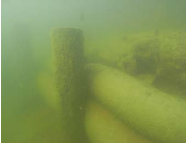
Abb. 7 - Risch Buonas ZG. Schutz der Abbruchkante mit zwei übereinander liegenden mit Kies gefüllten Geotextilwalzen. Foto P. Schwörer, Amt für Städtebau, Zürich.
