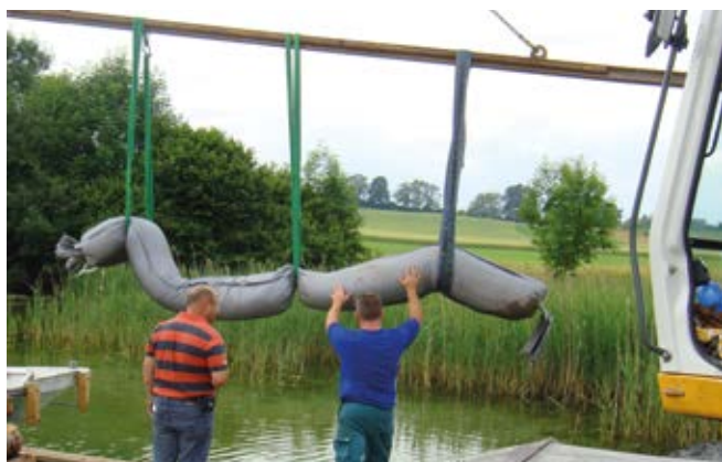
Abb. 5 - Risch Buonas ZG. Mit Kies gefüllte Geotextilwalzen werden zwischen der Kliffkante und den zuvor eingerammten Pfählen verlegt. Foto G. Schaeren, Amt für Denkmalpflege und Archäologie, Zug.
