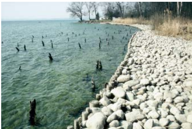
Fig. 1 - Première mesure de protection d'un site archéologique lacustre en Suisse. Corcelettes VD (lac de Neuchâtel). Palissade de mélèzes mise en place dès 1983. Cliché Denis Ramseyer, 1993.
