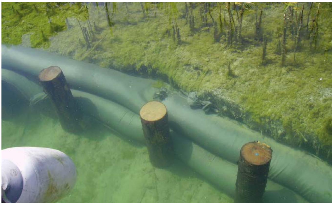
Abb. 6 - Risch Buonas ZG. Übereinanderliegende, mit Kies gefüllten Geotextilwalzen an der Kliffkante bei der Fundstelle Risch-Buonas. Foto D. Rossi, Tiefbauamt, Zug.
