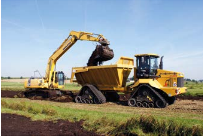
Abb. 6 - Durch Abtragung zersetzter Oberflächentorfe und Freilegung der intakten Mooroberfläche in Teilflächen ohne archäologische Befunde wurde das Material zur Grabenverfüllung gewonnen. Foto Reg.- Präs. Tübingen.
