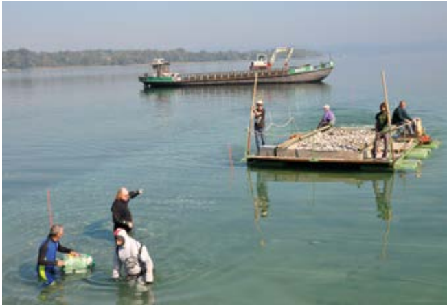
Abb. 8 - Steckborn-Schanz, Ausführung der Kiesschüttung durch die Arbeitsgemeinschaft Turgau-Baden-Württemberg, 2011. Der Kies wird mit einem Transportschiff angeliefert und dann jeweils mit dem Baden Württembergischen Verklappungsponton über die Einbringstelle geführt. Foto AATG.
