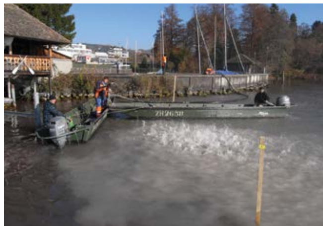
Abb. 4 - Meilen-Rorenhaab (UNESCO-Weltkulturerbe), flächige Abdeckung der gefährdeten Siedlungsbereiche mittels einer Kiesschüttung, welche unter Einsatz von Schlauch und Boot mit Luftdruck ins Wasser gepumpt wird. Foto UWAD.
