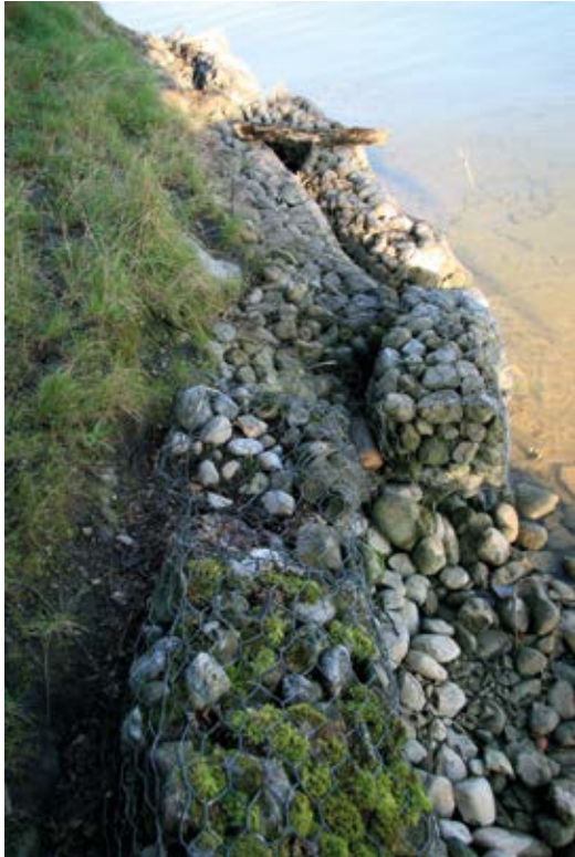
Fig. 12 - Schiffenen FR. a. Muret de pierre protégeant la berge, 34 ans après sa mise en place. b. Le même muret s'est écroulé en 2014, 40 ans après sa mise en place. Clichés Denis Ramseyer, 2014.
