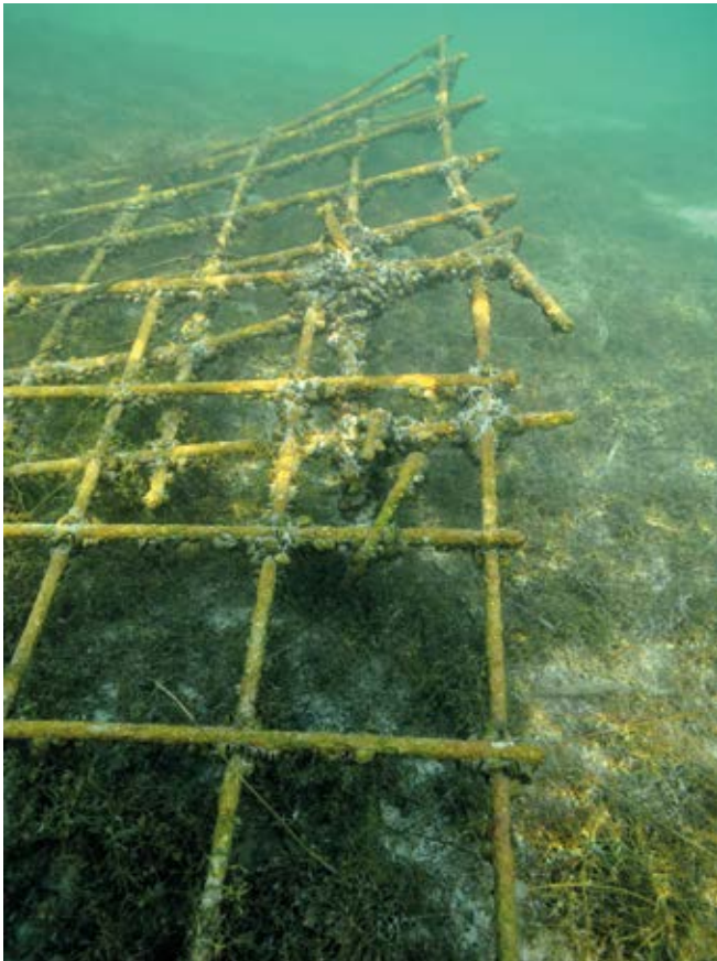
Abb. 5 - Durch Ankern beschädigte Stahlmatten, Ermatingen-Westerfeld. 2010. Foto AATG, M. Schnyder.
