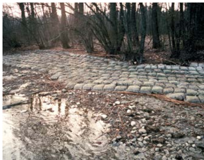
Fig. 6 - Sacs de graviers constituant la première tentative de protection de la rive pour la station de Font/Sous l'Épenex. Photo SAEF.
