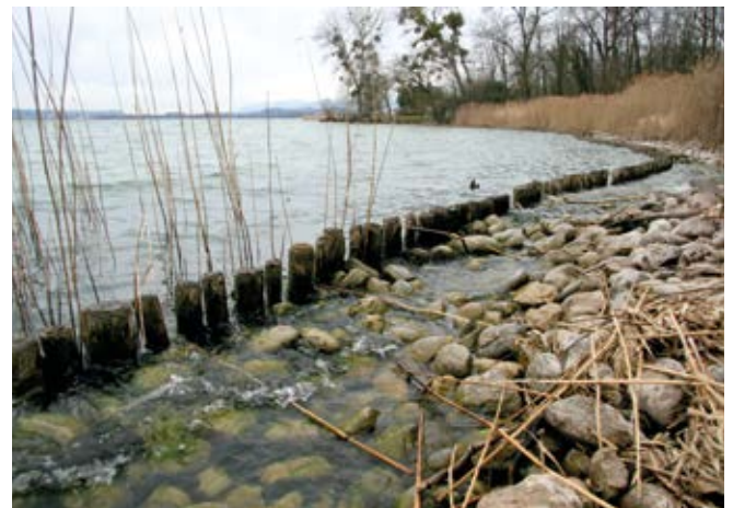
Fig. 2 - Corcelettes VD. L'ouvrage de protection 30 ans après sa mise en place. Cliché Denis Ramseyer, 2014.
