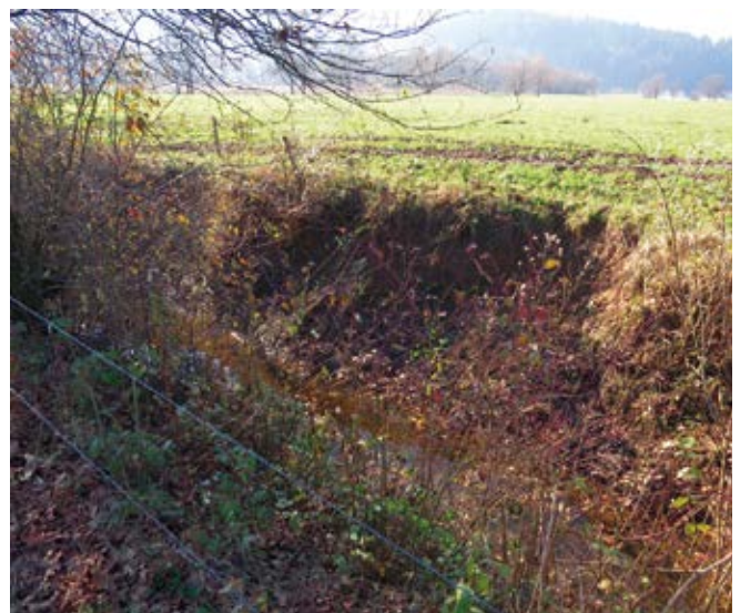
Fig. 9 - Il progressivo danneggiamento delle sponde del canale d'irrigazione, a causa del quale sono esposti i resti archeologici della palafitta di Hočevarica vicino a Verd. Foto A. Velušček.
