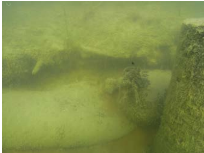
Abb. 9 - Risch Buonas ZG. Freiraum zwischen den Geotextilwalzen und der Abbruchkante: Hier greift die Erosion verstärkt an. Foto P. Schwörer, Amt für Städtebau, Zürich.
