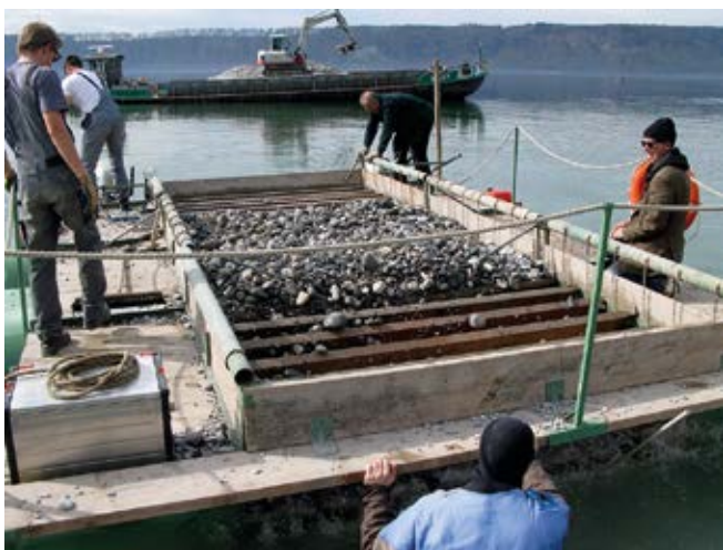
Abb. 2 - Spezialponton mit zwei geöffneten Segmenten des Jalousienbodens. Im Hintergrund ist mit Minibagger das Kiesschiff (LS Mary) zu sehen. Die Ladekapazität des Pontons erlaubt Kiesabdeckungen bis zu 30 cm Mächtigkeit. Pro Pontonladung können 15,5 m 2 abgedeckt werden. Foto LAD, J. Königer.
