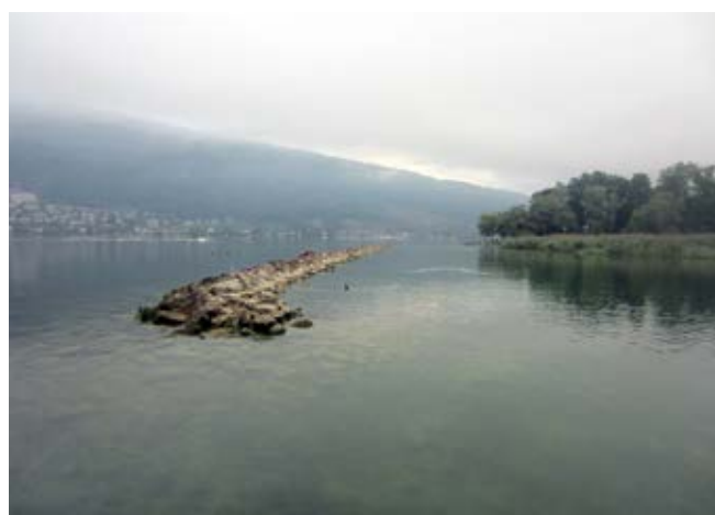
Abb. 14 - Blockwurf zum Schutz des Ufers in Ipsach. Vergleichbare Massnahmen würden zur Beruhigung des Wassers im Bereich archäologischer Fundstellen führen. Foto J. Fischer, ADB 2014
