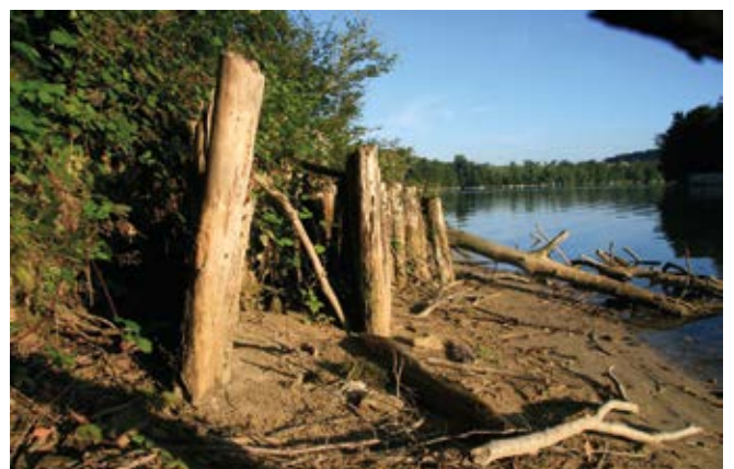
Fig. 11 - Schiffenen FR. État de la palissade de bois 16 ans après sa mise en place. Cliché Denis Ramseyer, 2014.
