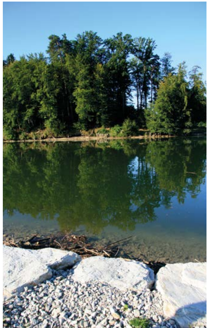
Fig. 13 - Vue de la ligne de rive protégée du site de Schiffenen FR. À l'arrière-plan, la palissade mise en place en 1998. Au premier-plan, le mur de blocs de pierre aménagé pour retenir la rive opposée. Cliché Denis Ramseyer, 2014.
