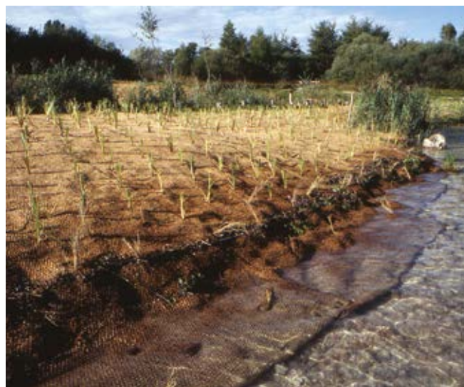
Fig. 4 - En 1995, la pose de géotextiles biodégradables et la plantation de végétaux a permis de freiner, en partie, l'érosion régressive. Photo P. Pétrequin.
