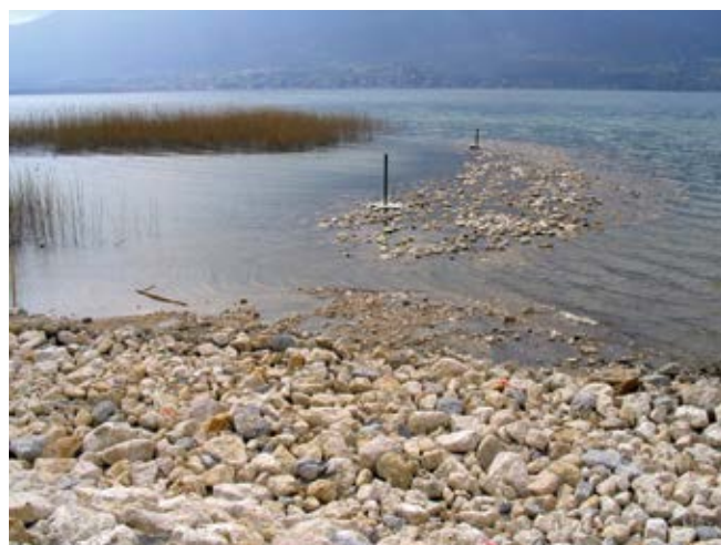
Fig. 9 - Pour respecter le site, un « épi », affleurant au niveau bas hivernal, a été construit en amont de la houle dominante.
