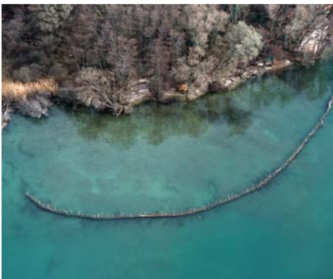
Abb. 6 - Sutz-Lattrigen, Rütte. 1998 wurde ein Wellenbrecher zur Beruhigung des Areals mit Kulturschichthaltung errichtet. Foto P. Nagy, KA Zürich, ADB.
