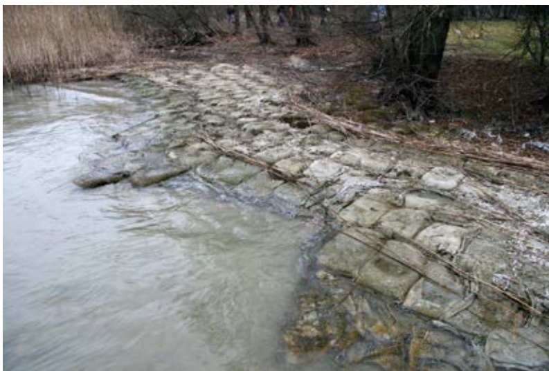
Fig. 3 - Forel FR. Le site néolithique recouvert de sacs de graviers en 1992. État des sacs 16 ans plus tard. Cliché Denis Ramseyer, 2008.
