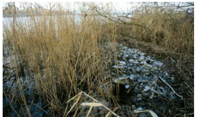
Fig. 9 - Greng FR. Le site protégé en 1998 vu 16 ans plus tard. La couverture de galets est encore en place, la végétation a envahi le secteur protégé. Cliché Denis Ramseyer, 2014.
