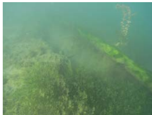
Abb. 7 - Meilen-Feldmeilen Vorderfeld, natürliche Hinterfüllung der Profilschutzwand in der Sprungturmgrube innert weniger Jahre: Zustand 2010 (a), 2011 (b), 2012 (c). Fotos UWAD.
