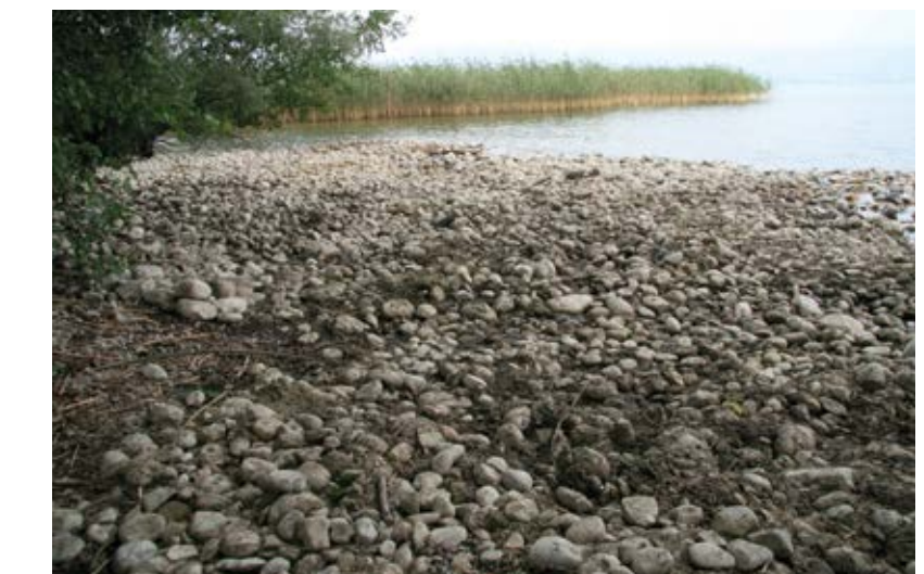
Fig. 6 - Font FR. Intervention septembre 2014. Mise en place d'un dépôt de galets par-dessus l'aménagement des sacs de graviers posés en 1992. Cliché Denis Ramseyer, 2014.
