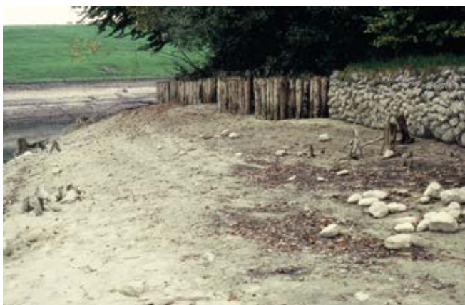
Fig. 10 - Schiffenen FR. Le secteur érodé protégé par une palissade en mélèze 10 ans après sa mise en place. Cliché Denis Ramseyer, 2008.
