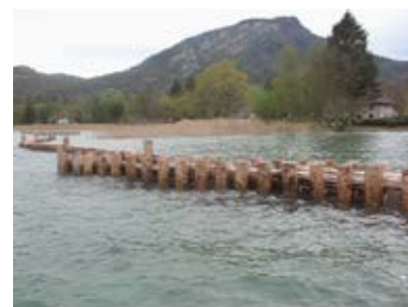
Fig. 12 - Ouvrages de protection mis en œuvre au lac d'Annecy, en particulier dans les secteurs pilotes du « Bout du lac » à Doussard, du « Sentier des roselières » et du « Marais de l'Enfer » à Saint-Jorioz. On remarque, sur la vue rapprochée, que les fascines sont surélevées à environ 30 cm du substrat, pour permettre la circulation de l'eau et des sédiments. © Documents SILA.
