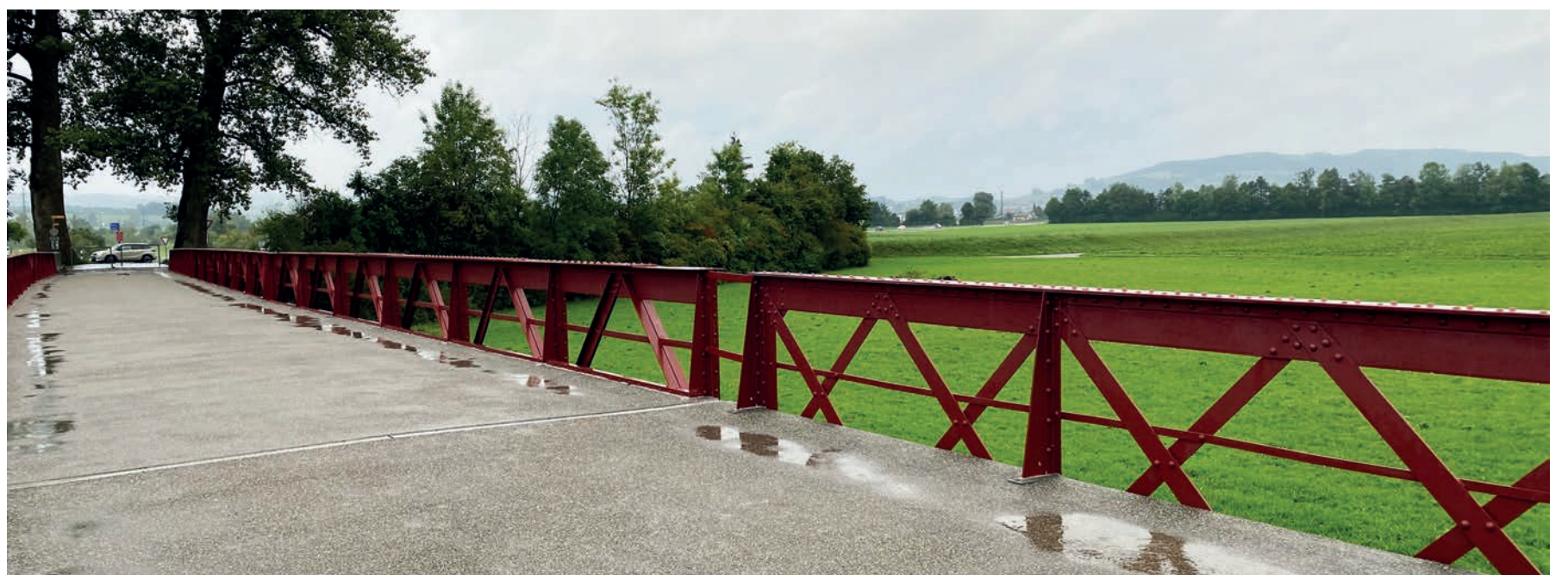
3 Erste Vorlandbrücke von 1886 (X-förmiger Verband), zweite Vorlandbrücke von 1911 (A-förmiger Verband).
