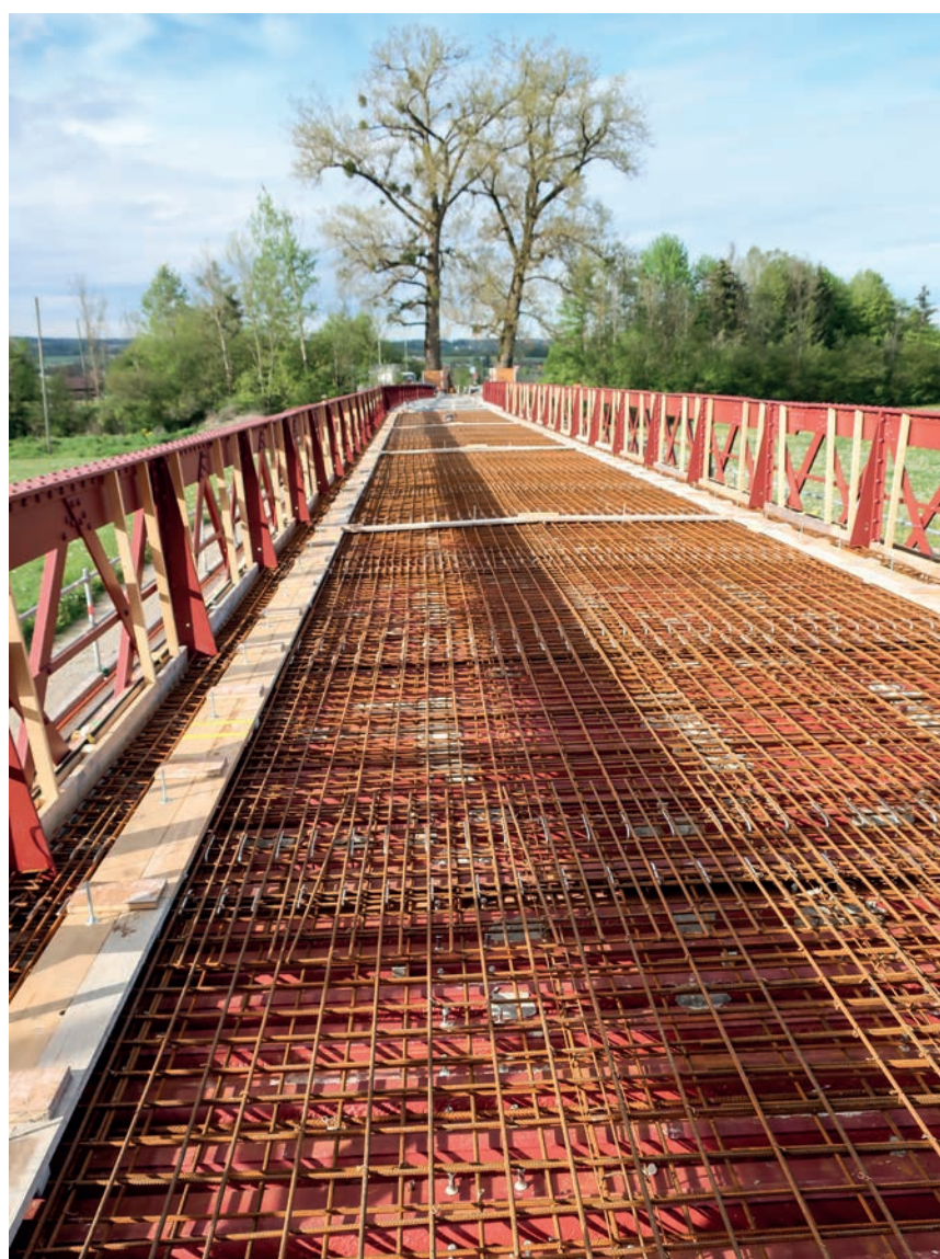
2 Neu gestrichene Stahlkonstruktion und Bewehrung der Fahrbahnplatte.
