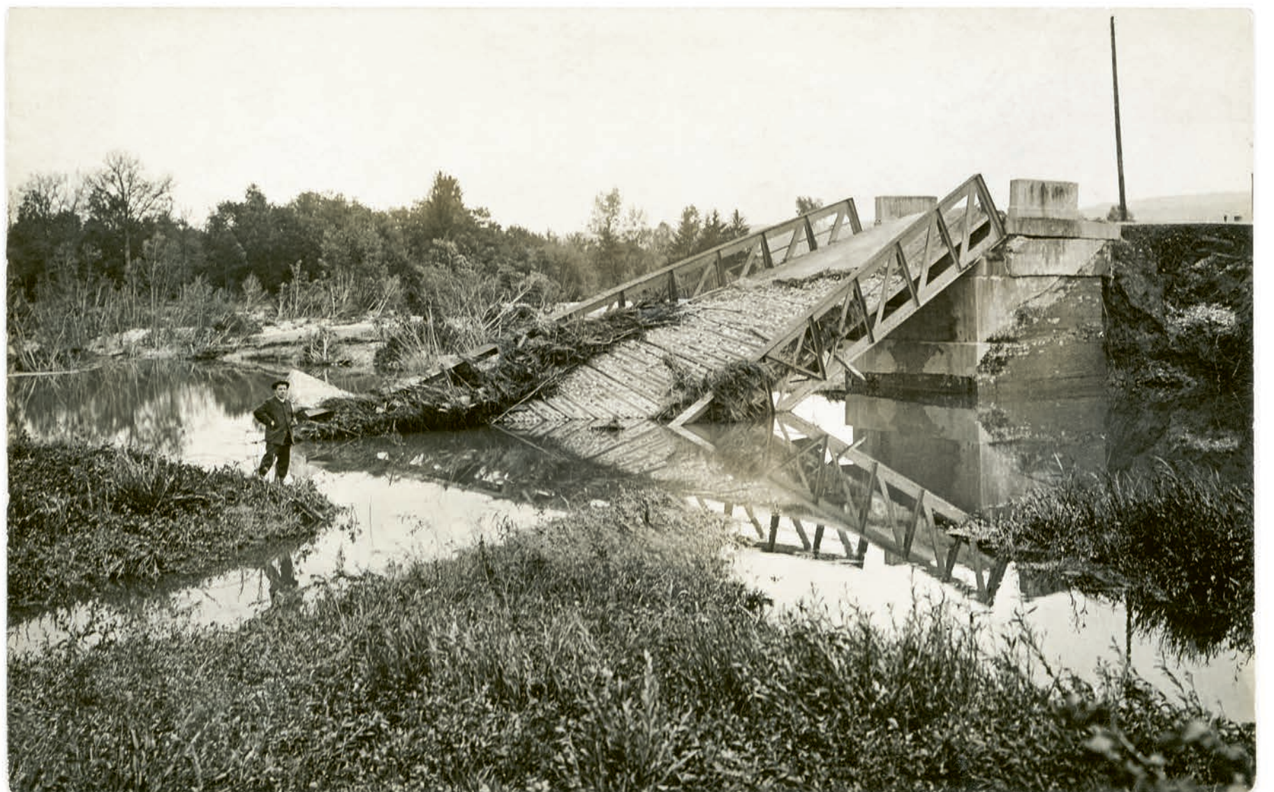
2 Die Binnenkanalbrücke stürzte beim Hochwasser von 1910 ein.
