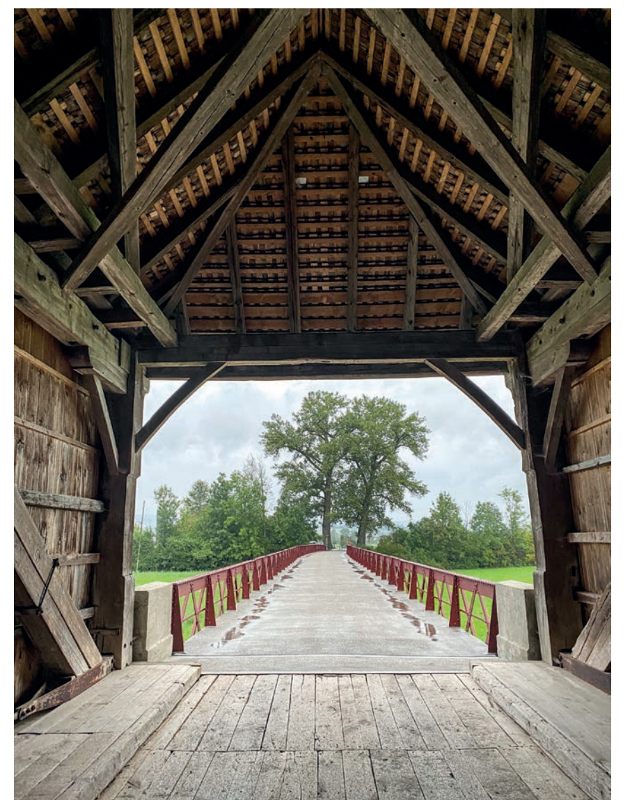
3 Blick von der Holzbrücke in Richtung Vorlandbrücke.
