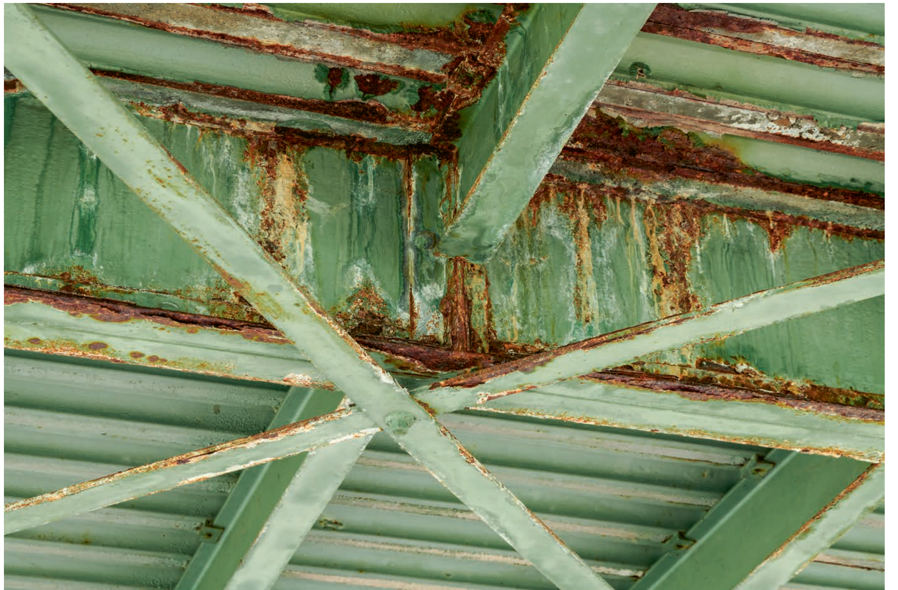
1 Originale Zorseisen an der Unterseite der ersten Vorlandbrücke (1885).
