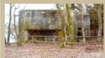
Der Bunker bei der Schaarenwiese.
