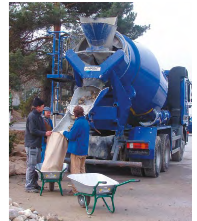
Fig. 7 - Nußdorf-Strandbad. Les préparatifs pour l'aménagement du talus. Une bétonneuse met les pierres de tailles différentes dans des sacs de jute.
