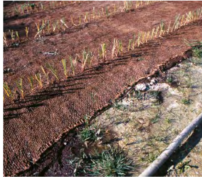
Fig. 5 - Exemple de protection, en 1995, d'une surface de craie lacustre émergée: épandage d'une couche de terre végétale mélangée à des semences, pose d'un géotextile biodégradable et plantation de roseaux. Cliché P. Pétrequin.
