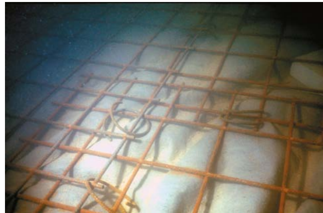
Fig. 8 - Ermatingen, Westerfeld. Géotextile et grillage mis en place.
