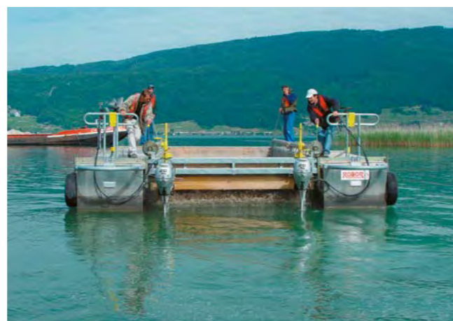
Fig. 5 - Sutz-Lattrigen – Hauptstation. Mesures de protection contre l'érosion 2003-2004. Décharge du gravier dans le catamaran « ROBOR » au moyen d'une petite excavatrice et d'une bande transporteuse.
