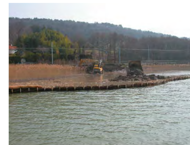
Fig. 15 - Aix-les-Bains, baie de Mémard (Savoie, lac du Bourget). À l'occasion des travaux du Conservatoire du patrimoine naturel de la Savoie, des fascines de piquets et de branchages brisent la houle et doivent permettre la végétalisation du littoral. Cliché AM/Drassm.
