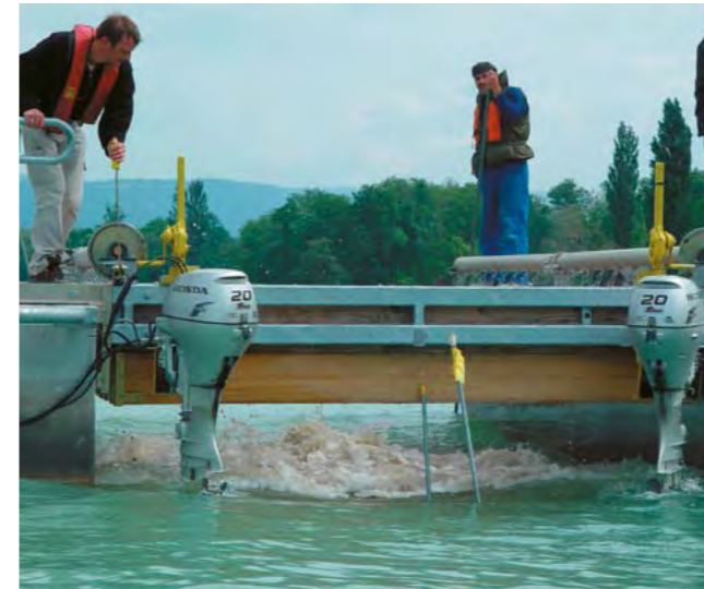
Fig. 6 - Sutz-Lattrigen – Hauptstation. Mesures de protection contre l'érosion 2003-2004. Déversement d'une couche de gravier sur le tapis en sable.
