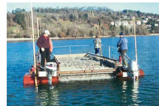
Fig. 2 - Le ponton flottant spécialement conçu par les ateliers du Service des Eaux de Constance permettant la pose de gravier. En haut : le fond ouvert du ponton flottant après largage des matériaux.
