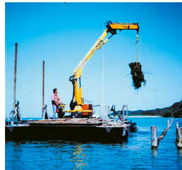
Fig. 6 - Pose de fascines de saule dans une palissade à claire-voie.
