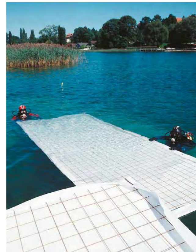
Fig. 2 - Sutz-Lattrigen – Hauptstation. Mesures de protection contre l'érosion 2000-2001. Pose des grilles recouvertes de géotextile à partir du radeau. En une opération de deux heures, il a été possible de poser environ 25 plaques.
