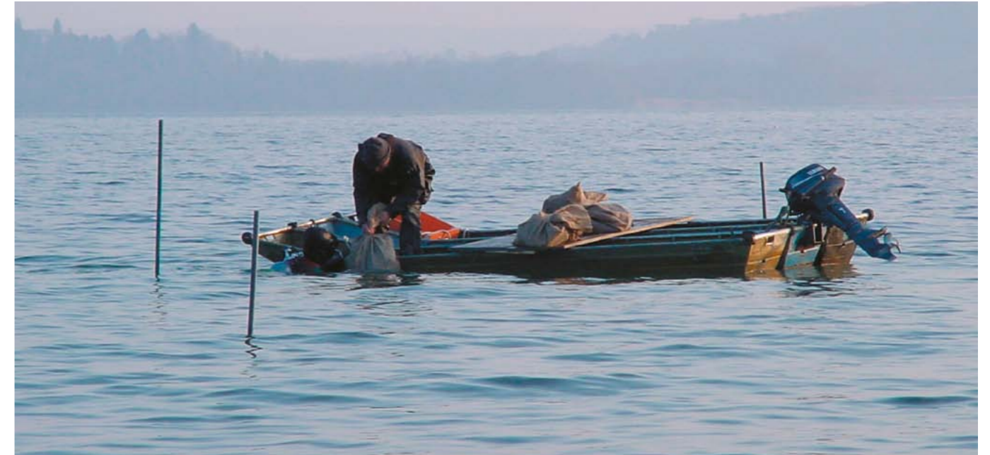
Fig. 6 - Nußdorf-Strandbad. Plongeur en train de stabiliser le talus. Des sacs de jute remplis de pierres de tailles différentes sont déposés manuellement sous l'eau.
