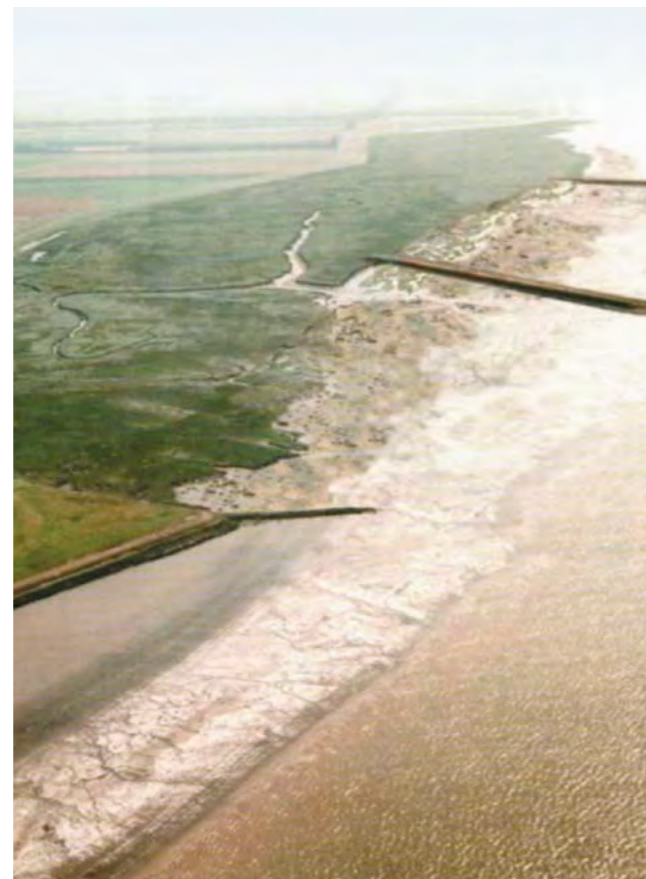
Fig. 3 - Remblais pour la protection du « village noyé » de Valkenisse, province Zeelande.
