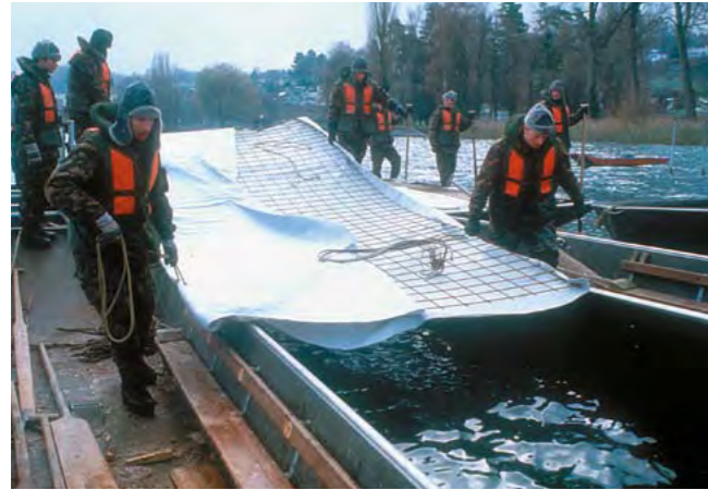
Fig. 7 - Ermatingen, Westerfeld. Pose d'un géotextile grillagé.
