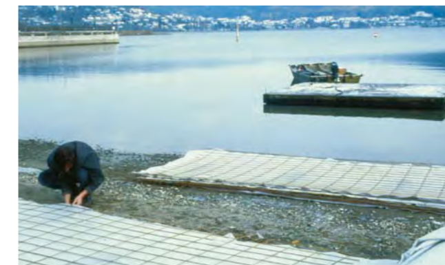
Fig. 3 - Bodman-Schachen I. Drapage des nattes de géotextiles sur des grilles en acier.
