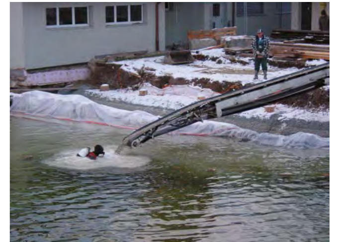
Fig. 16 - Maur-Schiffände ZH, rive gauche du Greifensee. On comble de gravier la zone inscrite entre la rupture de pente, fortement érodée en raison du port tout proche, et la paroi de protection.
