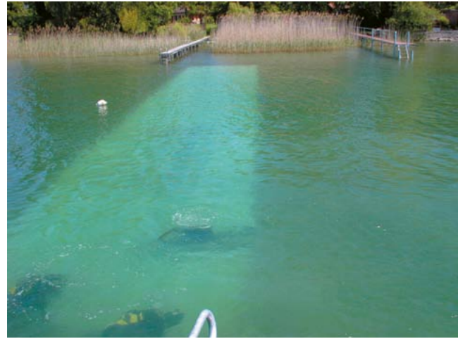
Fig. 4 - Sutz-Lattrigen – Hauptstation. Mesures de protection contre l'érosion 2003-2004. Une bande du tapis en géotextile de 30 x 5 m vient d'être déposée au fond du lac. Pour cette opération, il fallait l'intervention d'au moins deux plongeurs.
