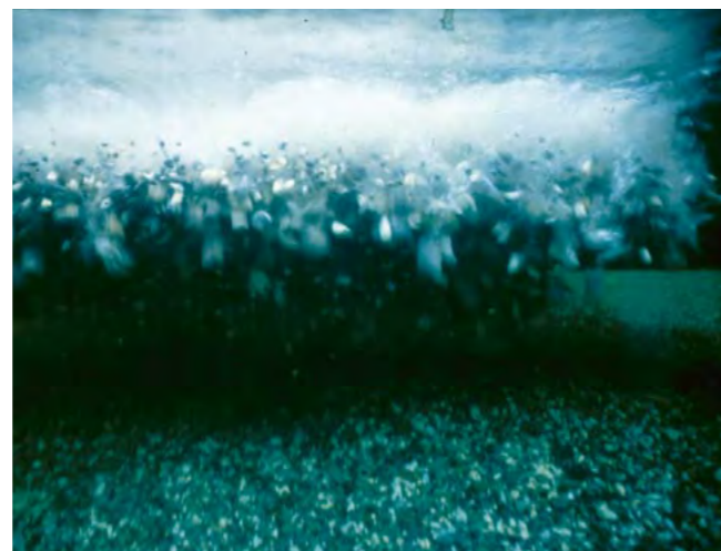
Fig. 5 - Bodman-Schachen I. Dépôt du gravier en perspective à ras de terre. Le matériel est déposé de manière plane à travers le fond spécial du ponton.
