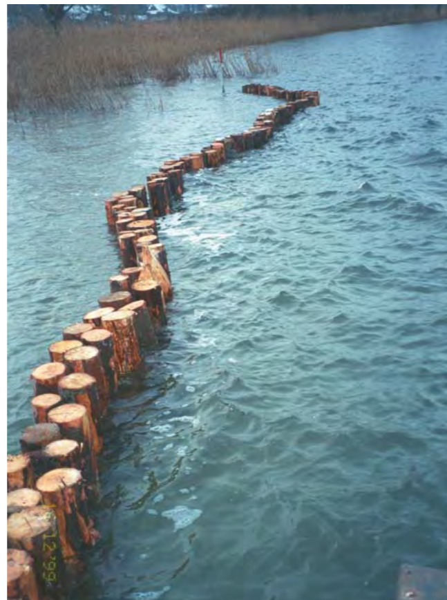
Fig. 2 - Pendant les dix dernières années, en divers endroits au bord du lac de Zoug, on a entrepris la mise en place de palissades en bois pour la protection des roselières. Ces mesures protègent aussi les stations lacustres contre l'érosion.
